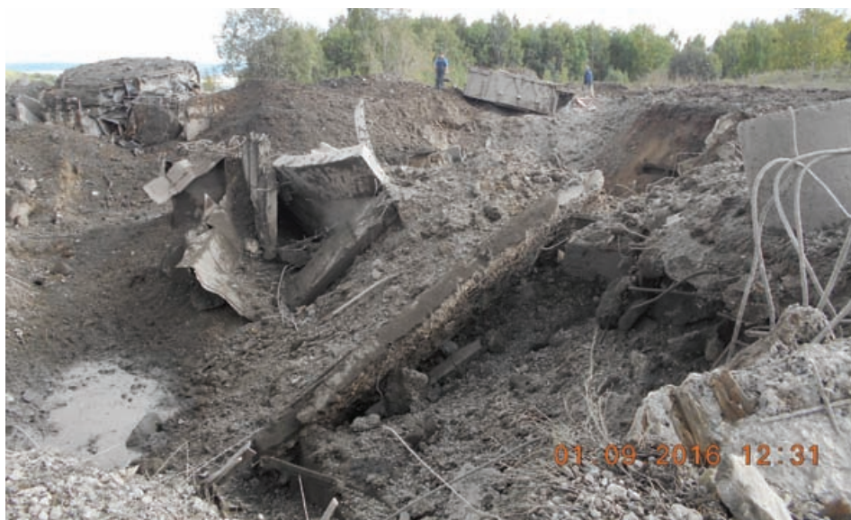
Рис. 3. Фрагмент ликвидированной площадки с ШПУ. Крышка шахты отброшена взрывом на значительное расстояние
