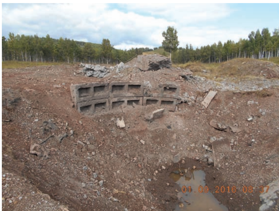
Рис. 2. Та же ШПУ месяц спустя после ликвидации её методом подрыва
