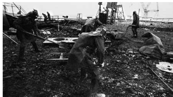
Рис. 1. Применение СИЗ из наполненной свинцом резины при выполнении работ на промплощадке ЧАЭС не приводило к значимому снижению индивидуальной дозы облучения, но значительно снижало работоспособность
