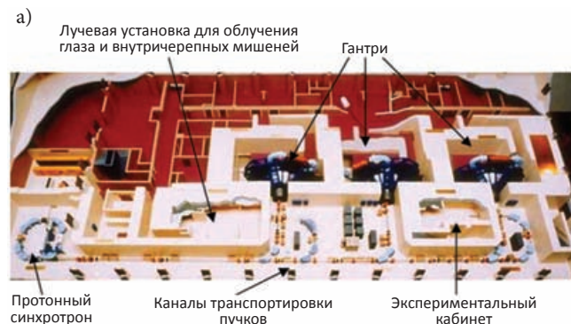
Рис. 8. (а) Макет первого в мире многокабинного центра ПЛТ в г. Лома-Линда, США, введен в эксплуатацию в 1990 г.
