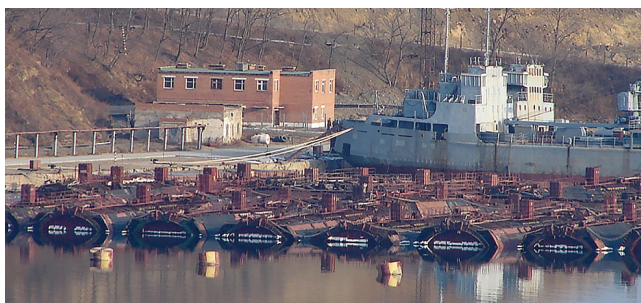
Рис.2. Хранение реакторных отсеков АПЛ «на плаву» Fig.2. Storage of nuclear submarine reactor compartments "afloat"
