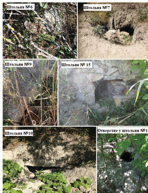
Рис. 2. Устья штолен Fig. 2. The tunnel mouths
